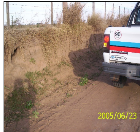
Fig. N°5. Profundización de caminos por erosión hídrica
